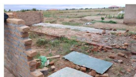
Unten: Mädchen WC's Rohbau
