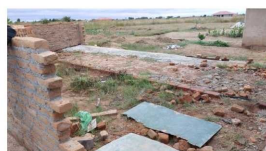
Unten: Mädchen WC's Rohbau
