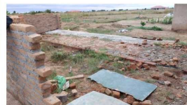
Unten: Mädchen WC's Rohbau
